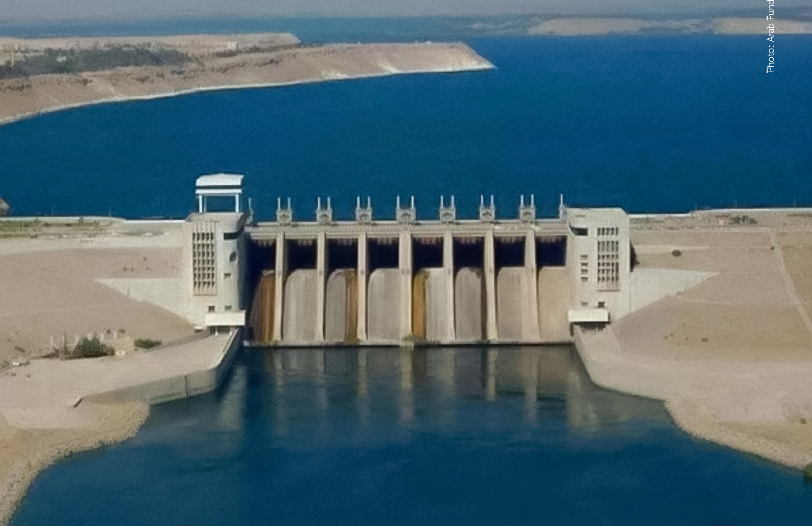
Sidi El Barrak Dam
